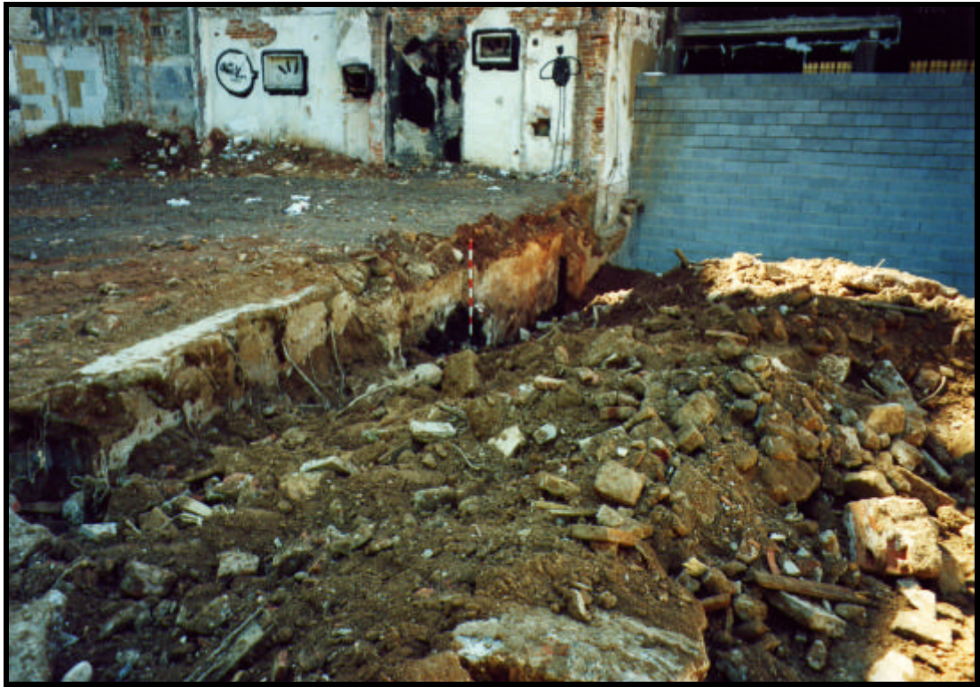
F. 11. Vista longitudinal de la cara est de la paret U.E. 206 amb la runa de l'enderroc al costat.
